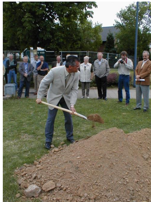
1. S1.Spatenstich zum Umbau der Halle 2001
